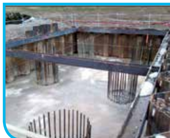
Réalisation des fondations
