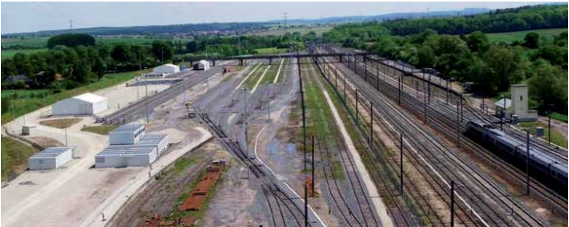
La base travaux de Réding en Moselle
