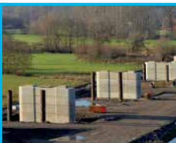
Mise en place des piles
