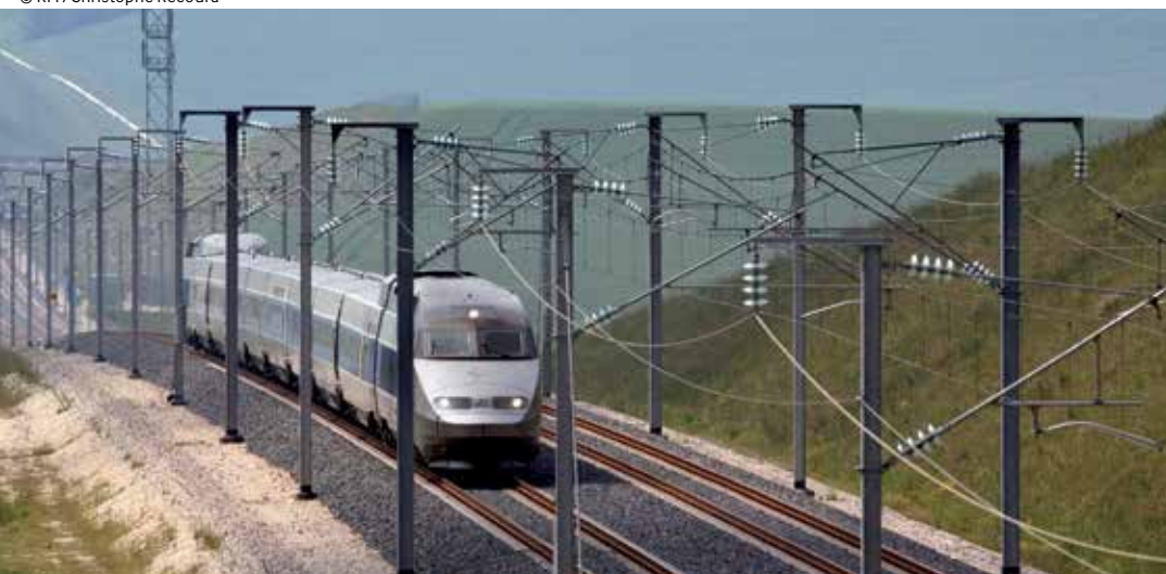
Passage d'une rame TGV dans la Meuse, sur la LGV Est européenne 1 re phase.
