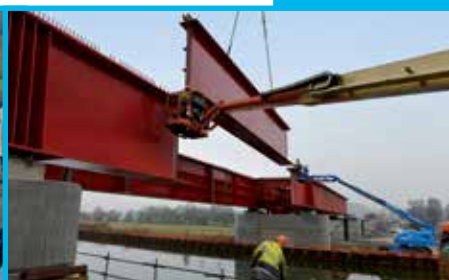
Pose des poutres métalliques à la grue
