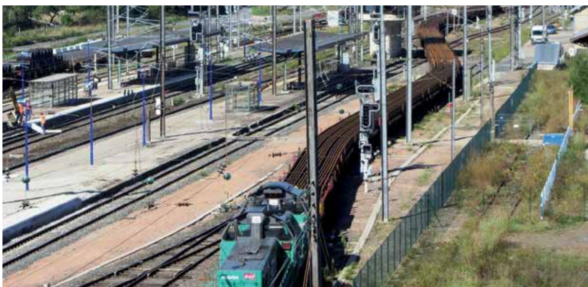
Acheminement des longs rails soudés sur la base travaux
