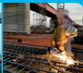
Travaux de soudure et de peinture
