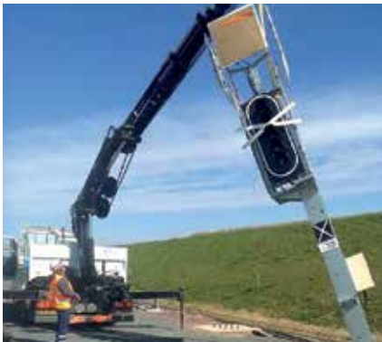
Pose du système de signalisation
