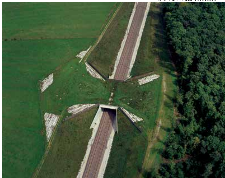
Dix passages grande faune sont prévus sur la LGV Est européenne 2 e phase, pour faciliter les déplacements des animaux.
