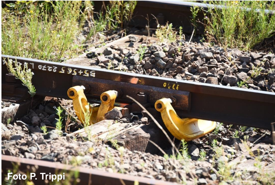
Foto: Das Gleis 2 in Lauterbourg wurde täglich von Güterzügen befahren
