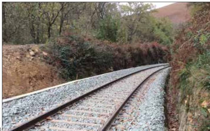
Traverses métalliques à grandes bèches (TMGB), voie à écartement normal, en courbe sur la ligne de Cambo-les-Bains à Saint-Jean-Pied-de-Port.
